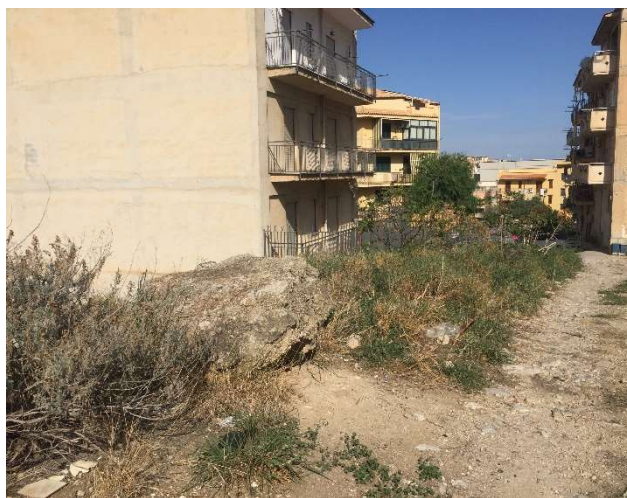
Fig. 7.1b – Blocchi detritici in prossimità degli edifici
