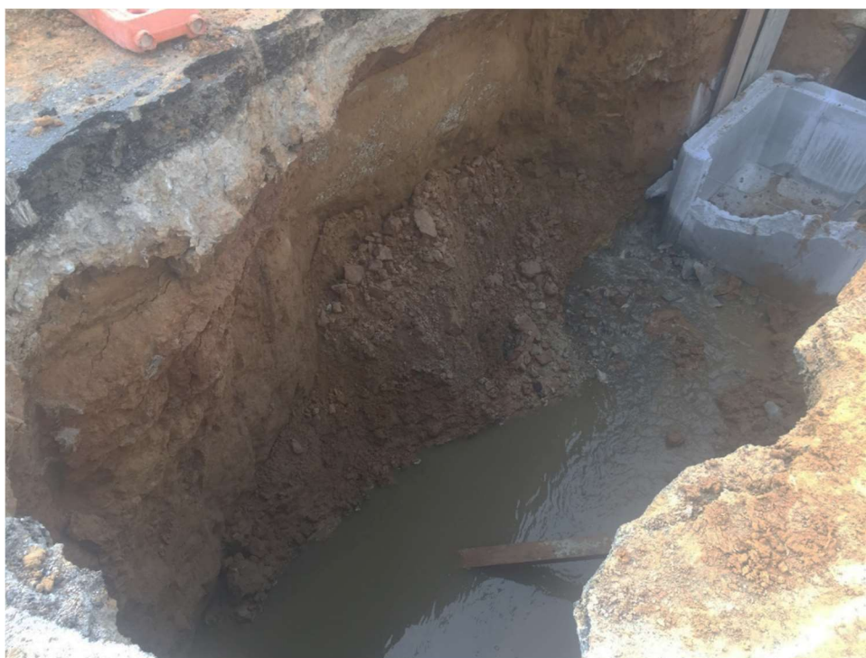
Fig. 5.2 – Sinkhole urbano in via Città di Palermo per rottura condotta fognaria – estate 2024 (Foto Lithostudi)
