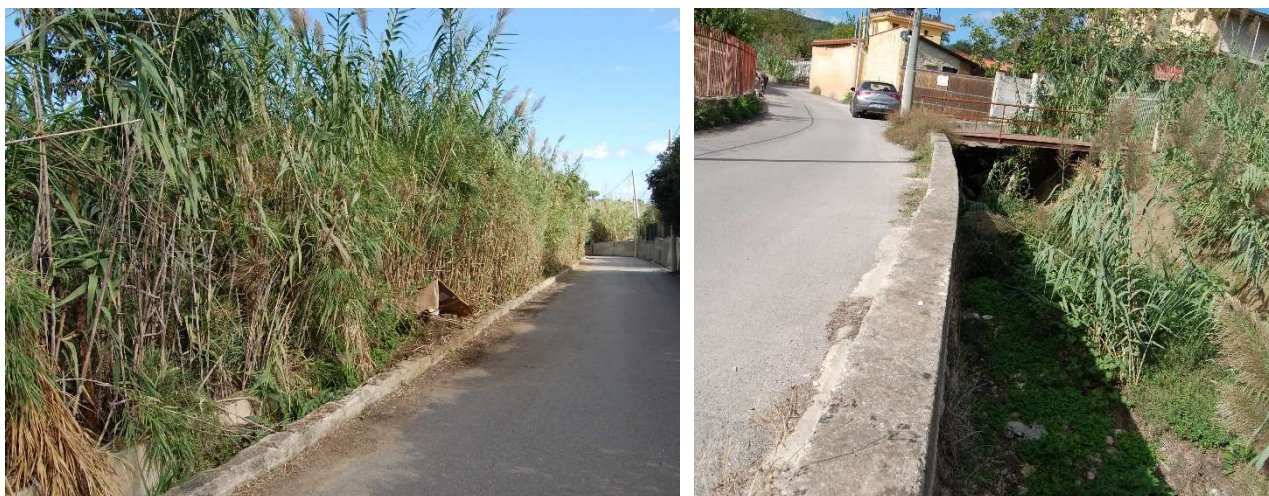
Fig- 7.2 – Strada Comunale Ranteria: Il canale di scolo intasato dai canneti (a) e la sezione in prossimità del Ponte Castronovo (b) nodo con la SP16 (Foto Lithostdi)
