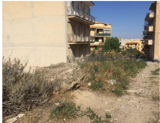
Fig. 1b – Blocchi detritici in prossimità degli edifici
