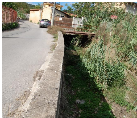
Fig- 6 – Strada Comunale Ranteria: Il canale di scolo intasato dai canneti (a) e la sezione in prossimità del Ponte Castronovo (b) nodo con la SP16 (Foto Lithostudi)
