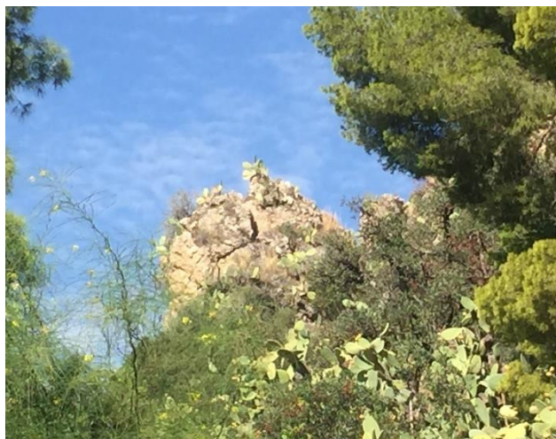
Fig. 2b - Particolare dello stato di fratturazione
