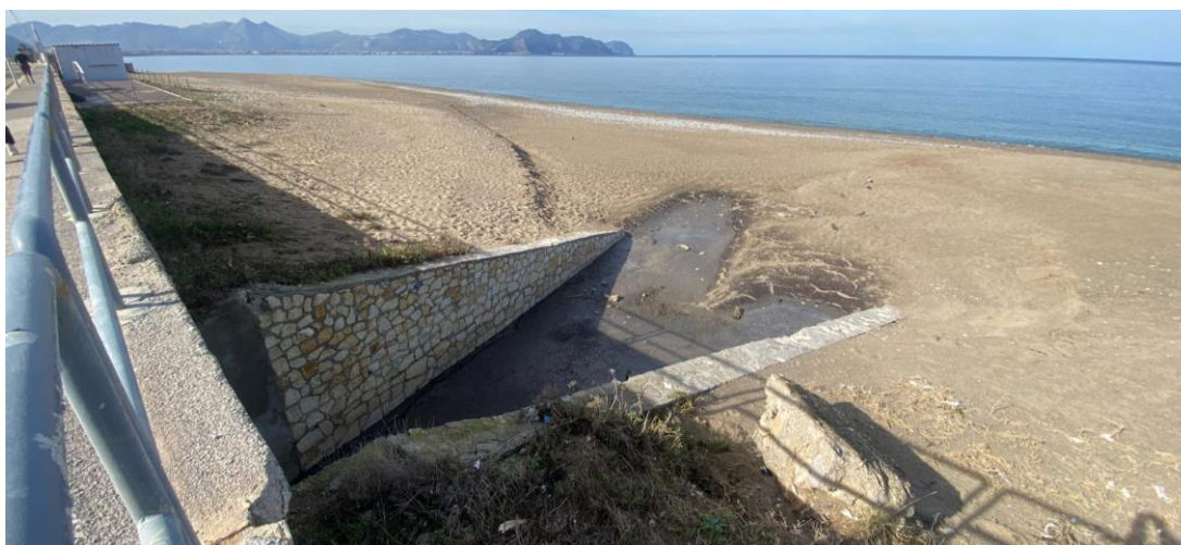
Fig. 7 – Sbocco del collettore fognario (Foto Lithostudi)
