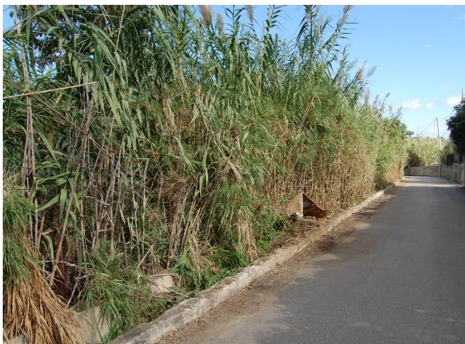
Fig- 6 – Strada Comunale Ranteria: Il canale di scolo intasato dai canneti (a) e la sezione in prossimità del Ponte Castronovo (b) nodo con la SP16 (Foto Lithostudi)
